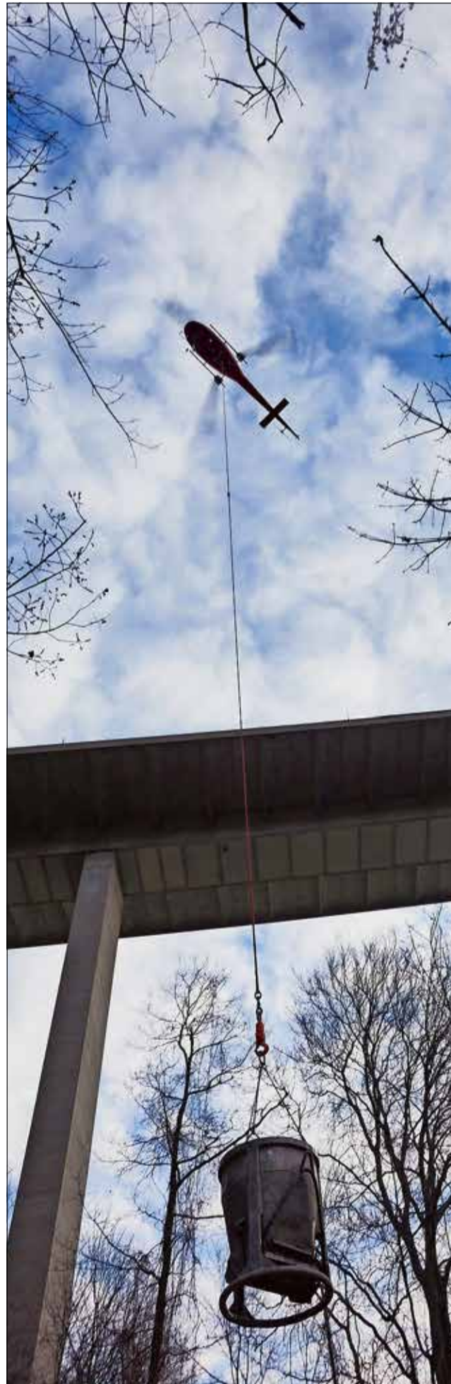
Suspendue au bout d'une élingue, la benne de béton se faufille à travers les arbres. Au sol, les ouvriers la stabilisent au-dessus des coffrages et tirent sur la poignée de largage pour laisser couler le béton. PHOTOS JEAN-BAPTISTE MOREL
